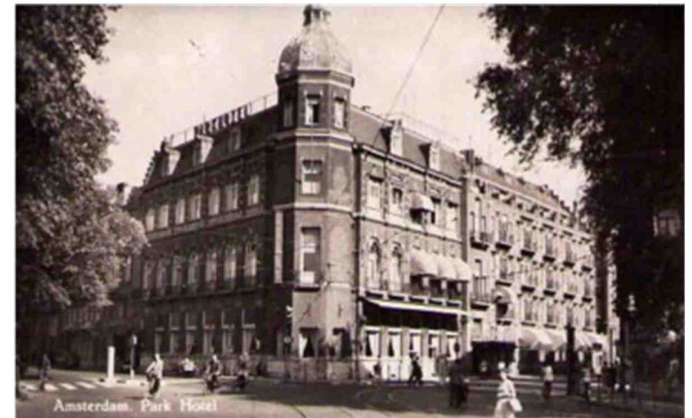
Parkhotel te Amsterdam met uitbreiding door Anton Joling.
